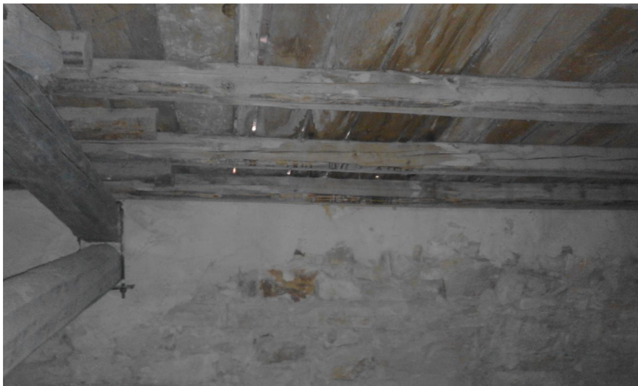
Figura 12: Evidenti forature tra la posa del tavolato per la mancanza in superficie di guaina e di manto di copertura
