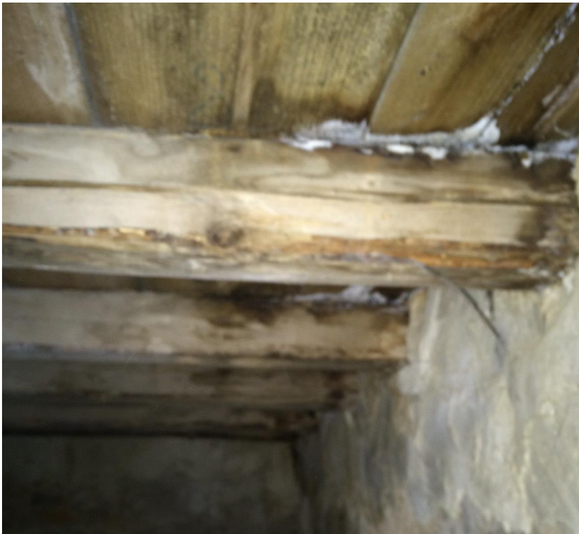
Figura 14: particolare delle travi ammalorate, presenza rilevante di muffe tra travi e tavolato
