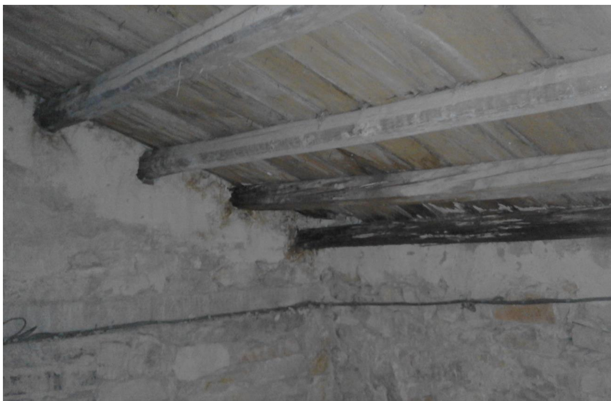
Figura 8-9: travi ammalorate della copertura
