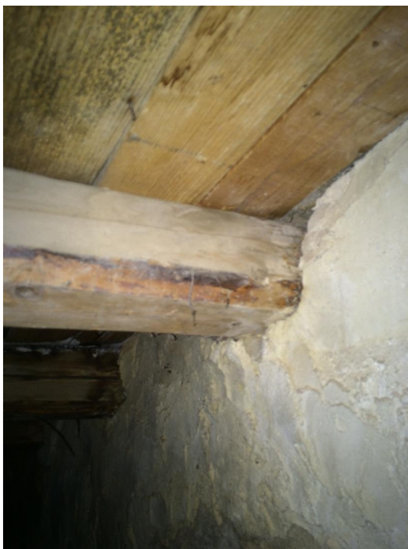
Figura 10-11. particolare d'innesto, evidenti danni alle travi
