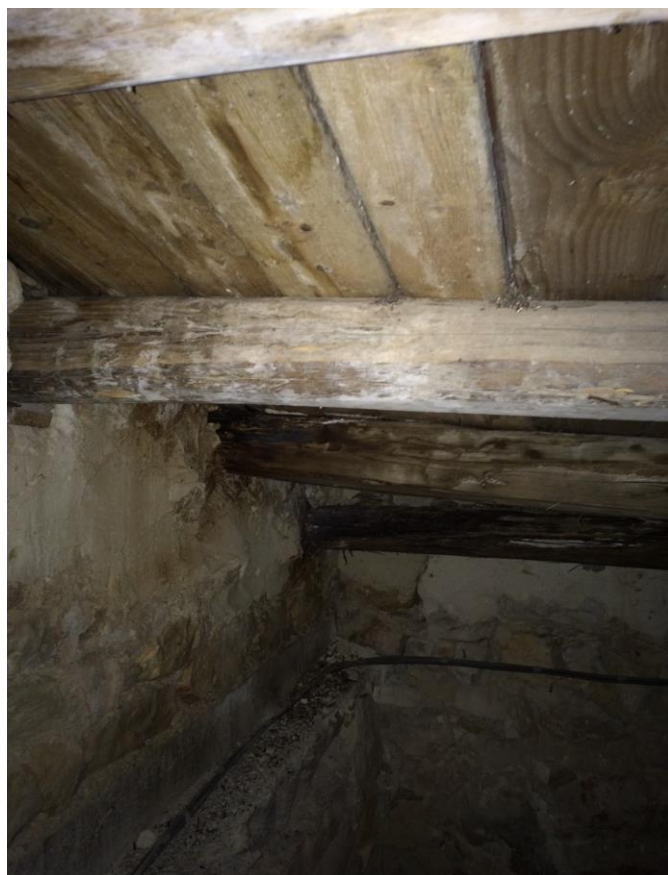
Figura 15: particolare delle travi ammalorate nella zona absidale
